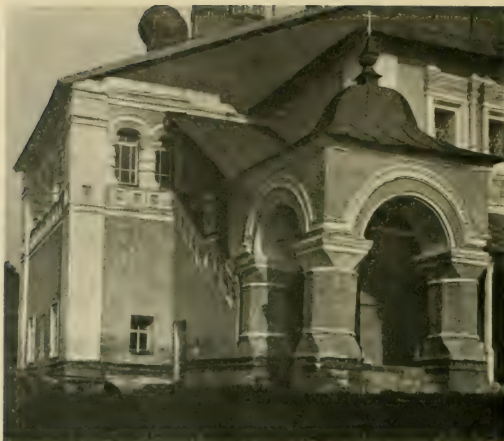
Входъ въ церковь Св. Троицы на Днѣпской горѣ.—1634 г.
